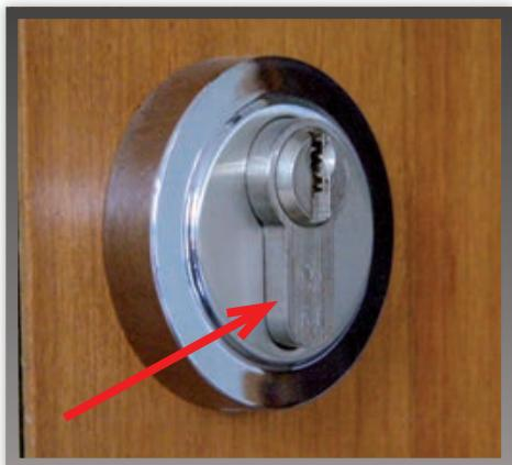
Vanjski dio cilindričnog uloška ne bi smio viriti više od 2 mm jer to provalniku omogućuje čvrst prihvati cilindra provalničkim alatom i lomljene tijela cilindra, nakon čega ima slobodan pristup mehanizmu brave te vrlo brzo ulazi u stan.
